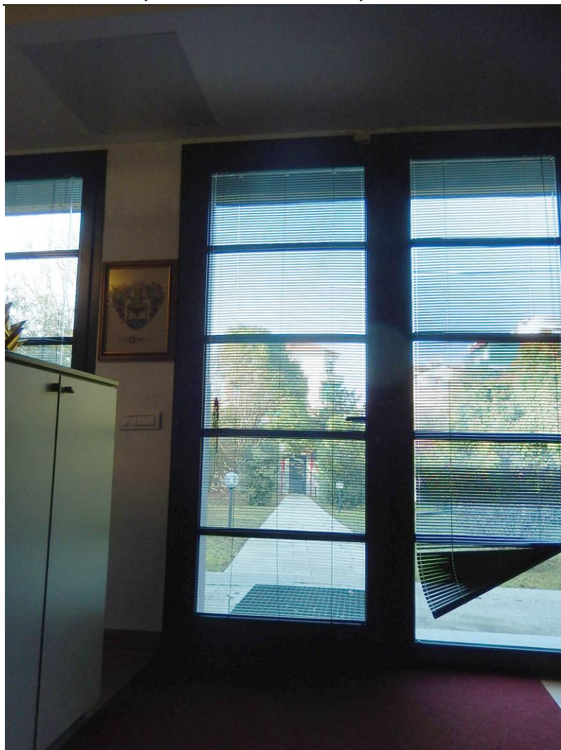
Foto 6 – La porta d'ingresso principale dal lato giardino.
